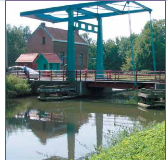
Kanaal Dessel-Schoten, brug Wezelsebaan
